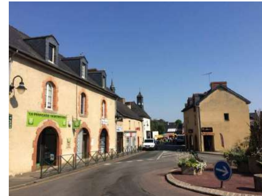
Avenue Brizeux Ces maisons de ville mitoyennes forment un ensemble bâti accompagnant la Mairie. Elles forment un front bâti dense et urbain, encadrant la Mairie.
