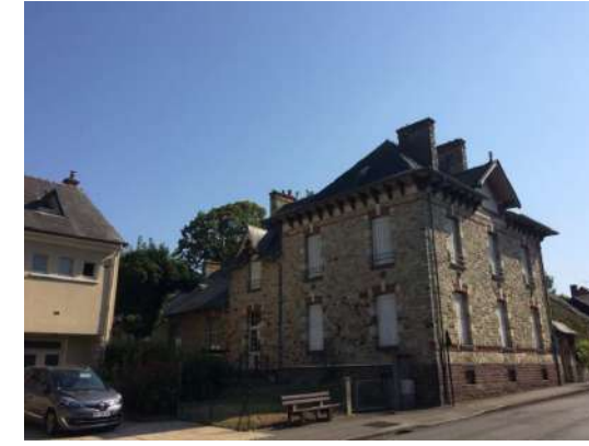
Avenue Brizeux Remarquable par son gabarit et son architecture, l'école de musique se distingue par un appareillage composé de schiste en soubassement et de grès. Une liaison douce le long de sa façade permettra de rejoindre An Diskuiz.
